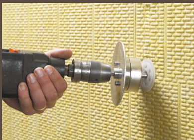
Skrue og fræs dyvlen ind i isoleringen i én arbejdsgang.
